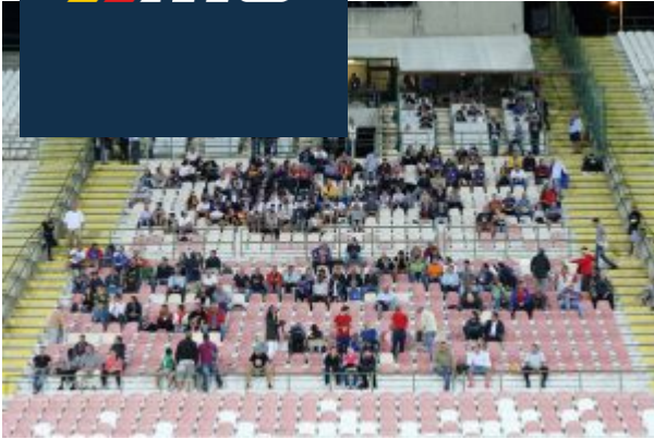
La copertura della tribuna stampa del "Franco Scoglio" va sostituita
