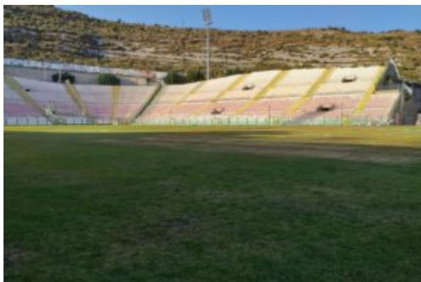
Un'altra porzione di terreno danneggiata dopo i concerti
