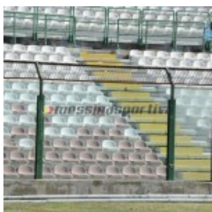
Una delle vetrate del "Franco Scoglio" rimesse a norma in occasione dei recenti concerti
