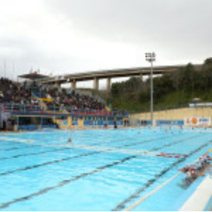
panoramica dell'impianto Cappuccini
