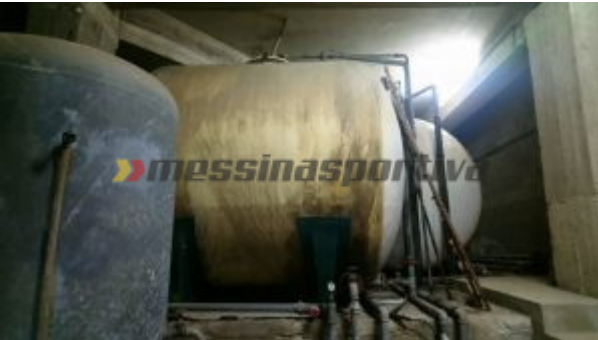
Riattivate le sei cisterne dell'impianto
