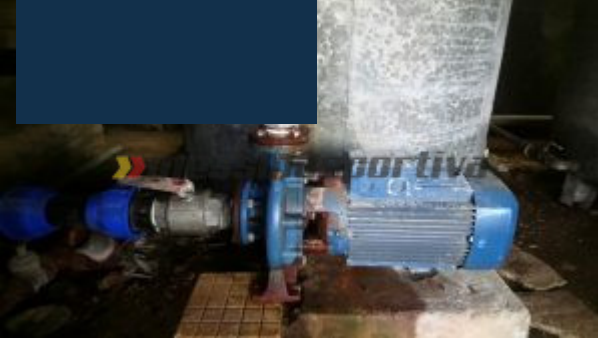
Ripristinato il motore dell'impianto d'irrigazione
