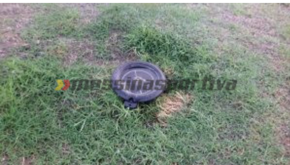
Uno degli irrigatori collocati all'interno del terreno
